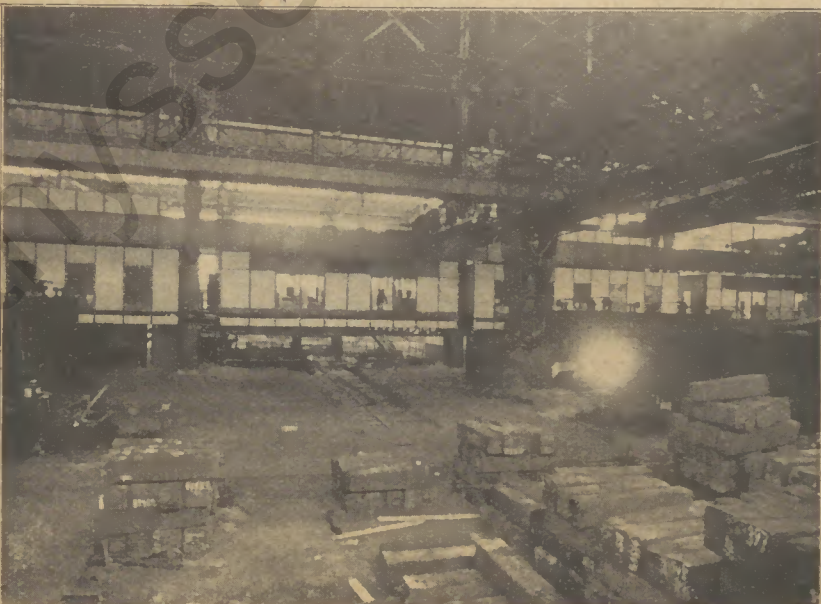
Ofenhalle / Ausziehen eines Blockes
