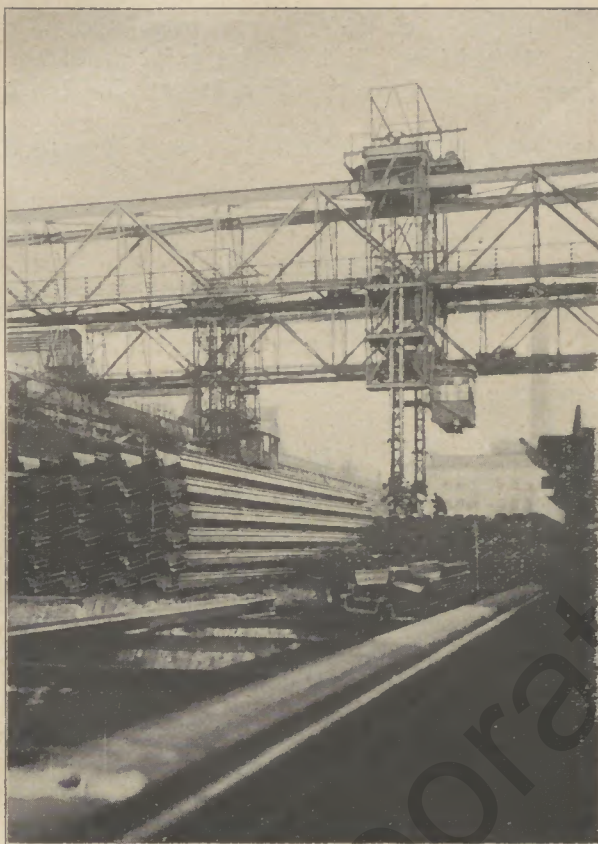
Barfensbohlenlager Aufnahme: Zentralwerbestelle
