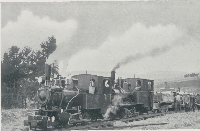
Henschel-Baulokomotiven bei der Arbeit
