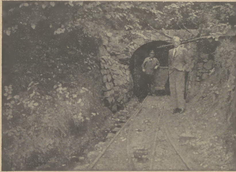
Betriebsführer und Steiger der Zeche „Elisabethenglück“ im Hammertal am Stollenmundloch (1934)
