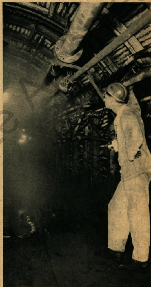
▼ Staubmesser Lothar Köster am Düsenring auf der 2. Teilsohle der 1. südwestlichen Abteilung, Kaiserstuhl-Westfeld
