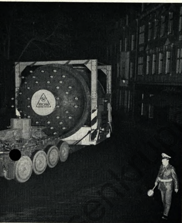
Spezialwagen der Bundesbahn. Unter Polizeischutz wurde der 40 t schwere Behälter nachts vom Werk Poensgen zum Neuffer Hafen gebracht. Von hier aus erfolgte die Weiterfahrt zur BASF nach Ludwigshafen per Schiff.
