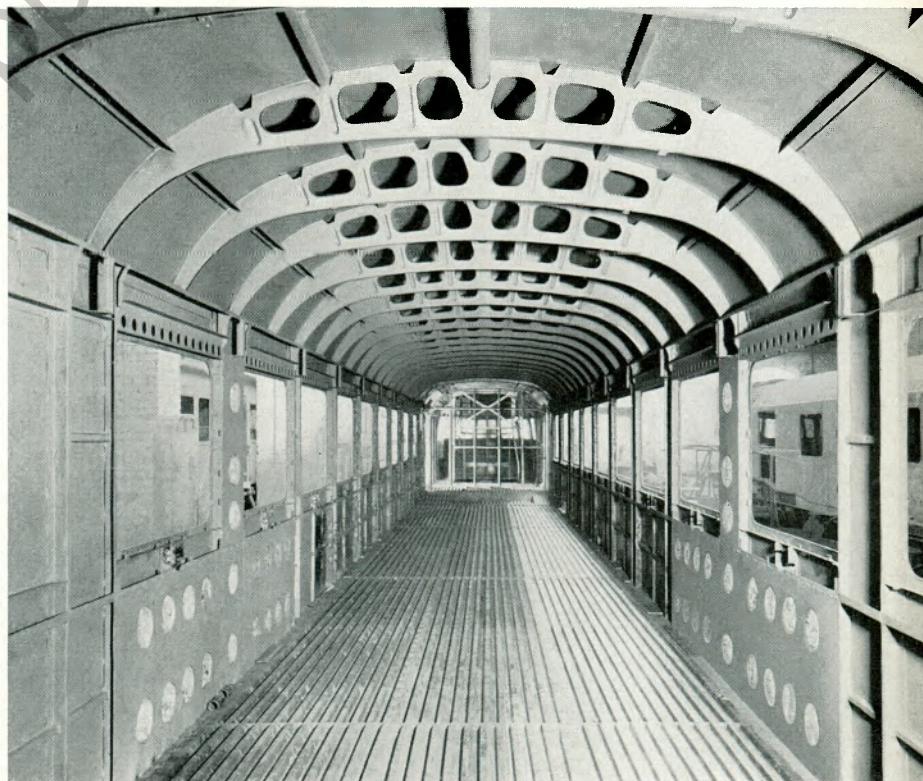
Wagenkastengerippe in Schalenbauweise, Dieseltriebzug der Bauart VT 08
