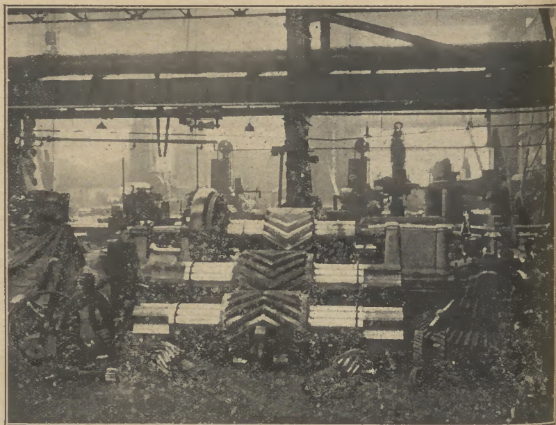
Rammwalzen, Stirnräder u. Kegelhäder mit geschnittenen Zähnen. Erzeugnisse der Preßwerk-Werkstatt der Dortmunder Union.
