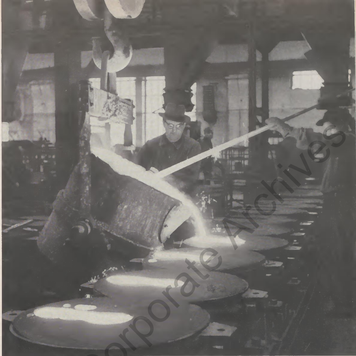
Abguß von Formen auf Rollbändern; links Henner Heinemann, rechts Martin Ledderhose
