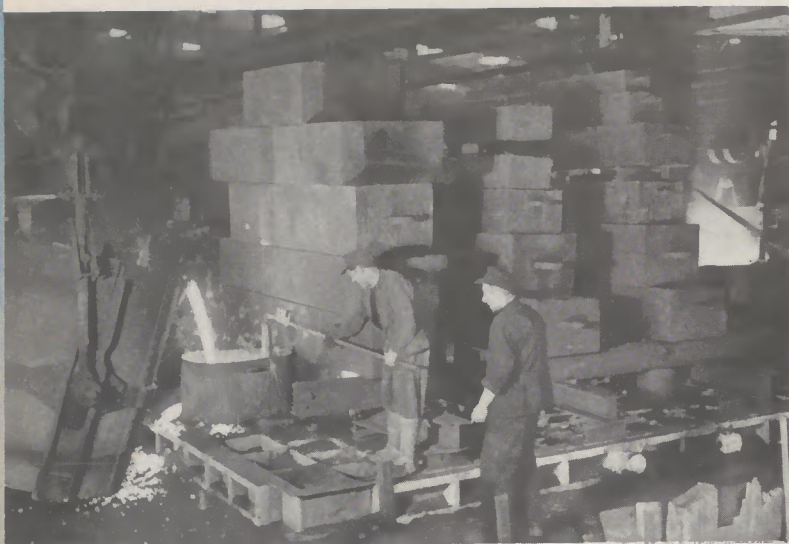
Eine Großform wird gegossen
