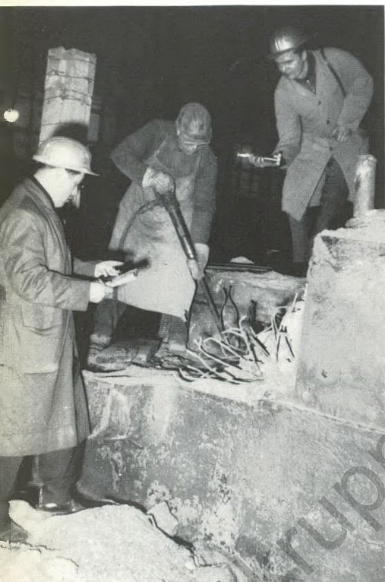
Bild 3 Staubbestimmung mit dem optischen Meßgerät
