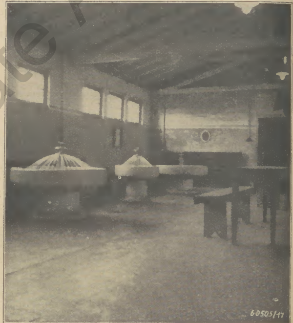
Waschtaue mit Waschbrunnen in der Lehrwerkstatt Henrichshütte
