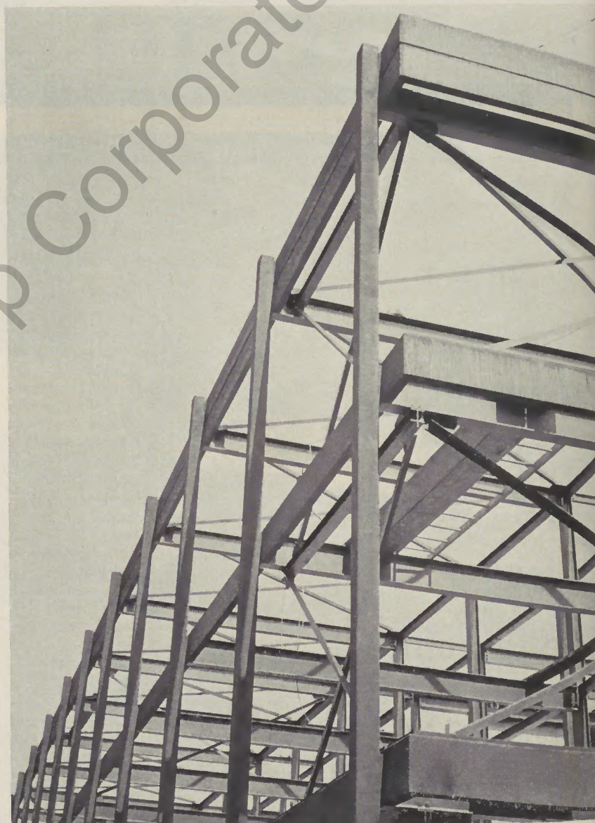
Teilansicht der Stahlkonstruktion mit den außenstehenden wassergefüllten Stahlstützen.
