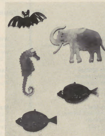
Proben von Brennschneidarbeiten nach Schablone. Es erhöht die Arbeitsfreude, wenn gelegentlich das Praktische mit dem Schönen verbunden wird.
