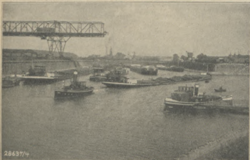
Bild 5: Stichhafen mit Waggontipperbrücke, 55 t Tragfähigkeit
