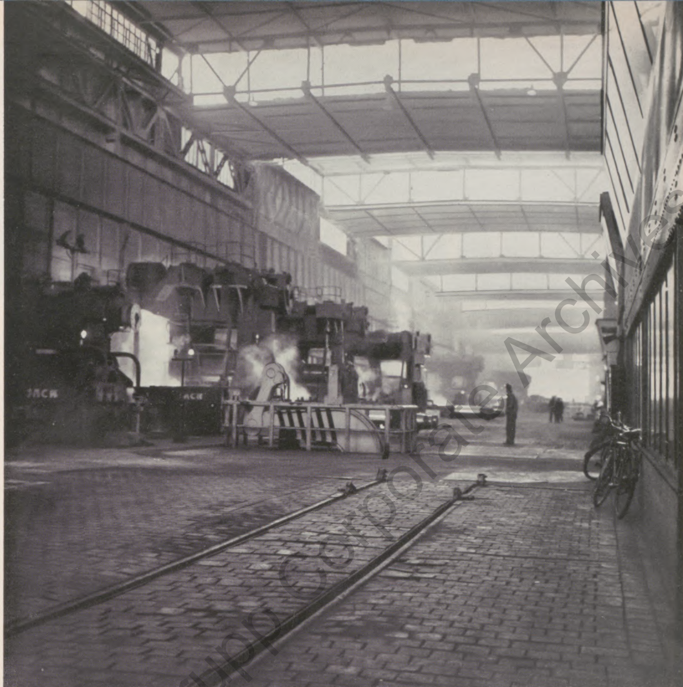
In der Warmbreitbandstraße der ATH
