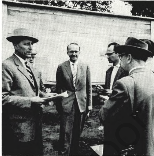
Oberbaurat Tussing (links) erläutert der Lokalpresse an der Baugrube die Pläne der neuen Thyssenbrücke
