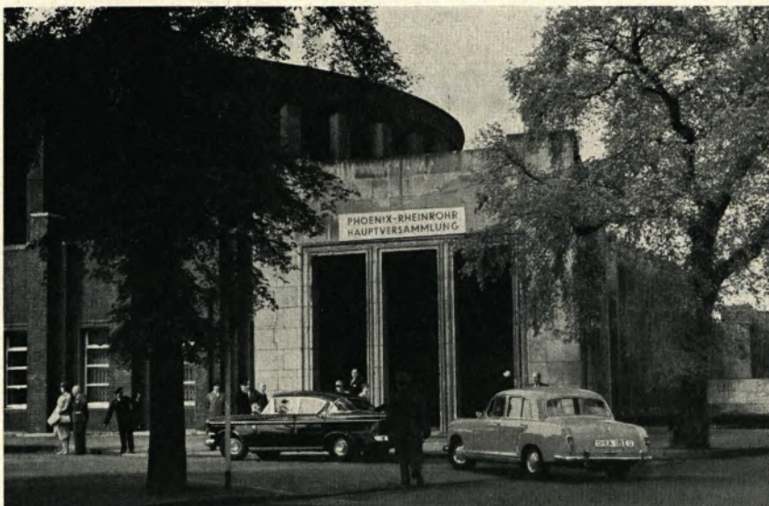
Die Rheinhalle, deren Kuppel wir 1947/48 in Stahlrohr konstruierten und bauten, diente erstmalig als Tagungsort für die Hauptversammlung. Das Foto zeigt den Eingang zur Halle
