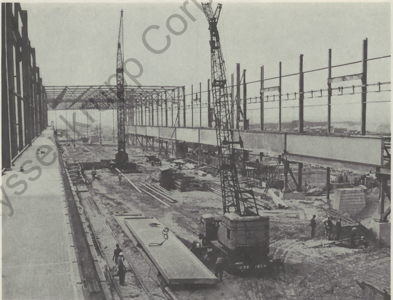
Bild 3: Lagerhalle an der Nordseeküste
