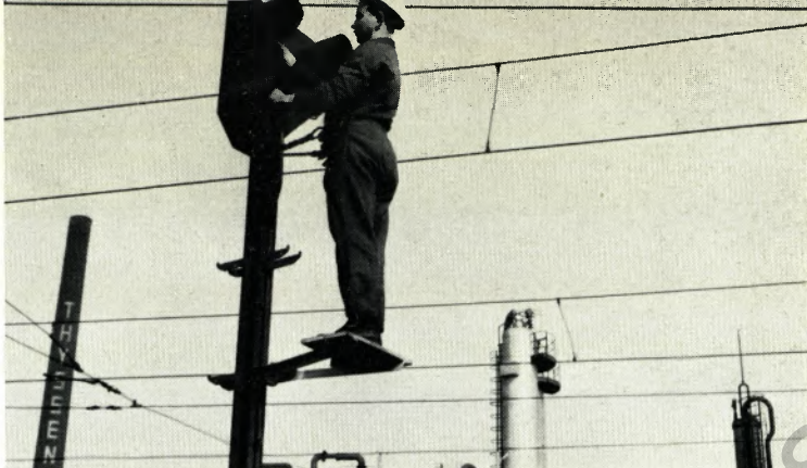
Arbeiten am Signalmast mit neuem Sicherheits-Arbeitstritt.
