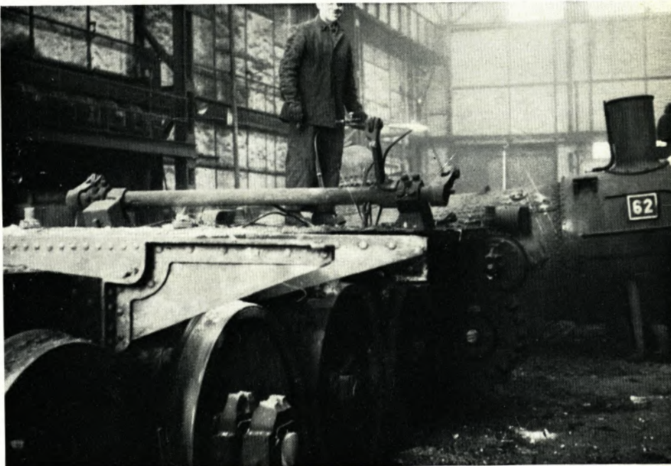
Die Bilder 2 und 3 zeigen die verschiedenen Stadien der Verschrottung.
