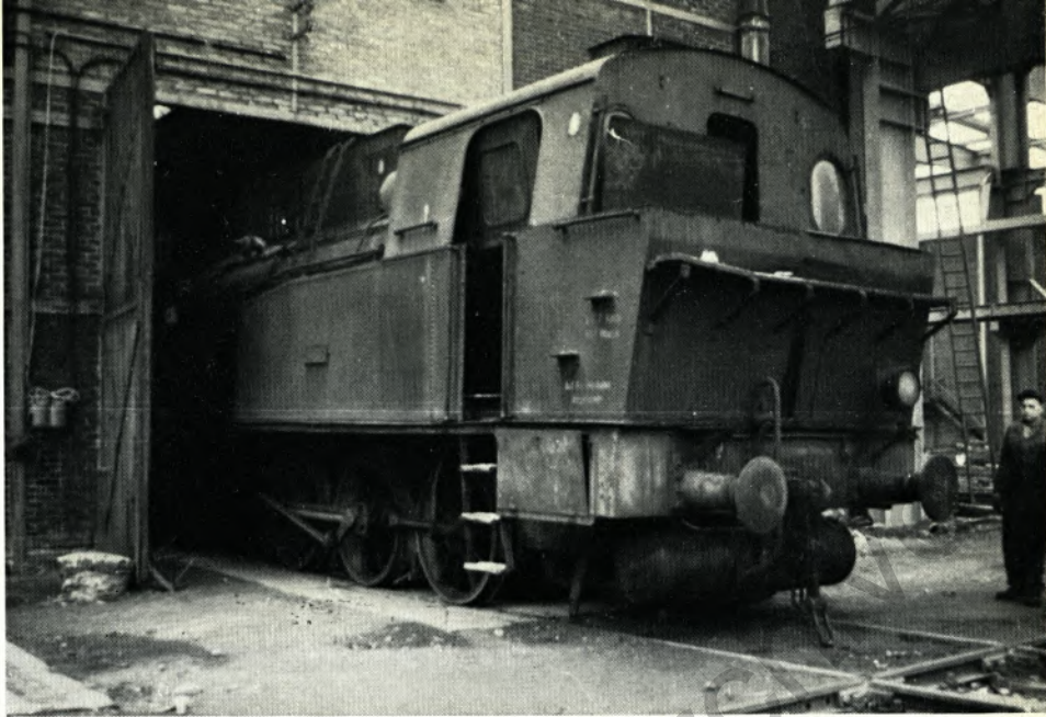
Als letzte Dampflokomotive des Gemeinschaftsbetriebes wird die Lok Nr. 62 zur Verschrottung in die Kesselschmiede der EBW gezogen.
