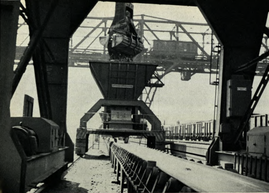
Der fahrbare Bunkerwagen wird vom Portalkran 15 mit Erz beschickt.
