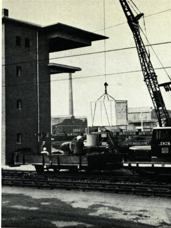
Hier schwebt die Kiste schon einige Meter über dem Boden.
