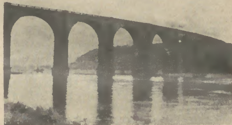
Viadukt bei Herbede. (D. Hengstenberg.)
