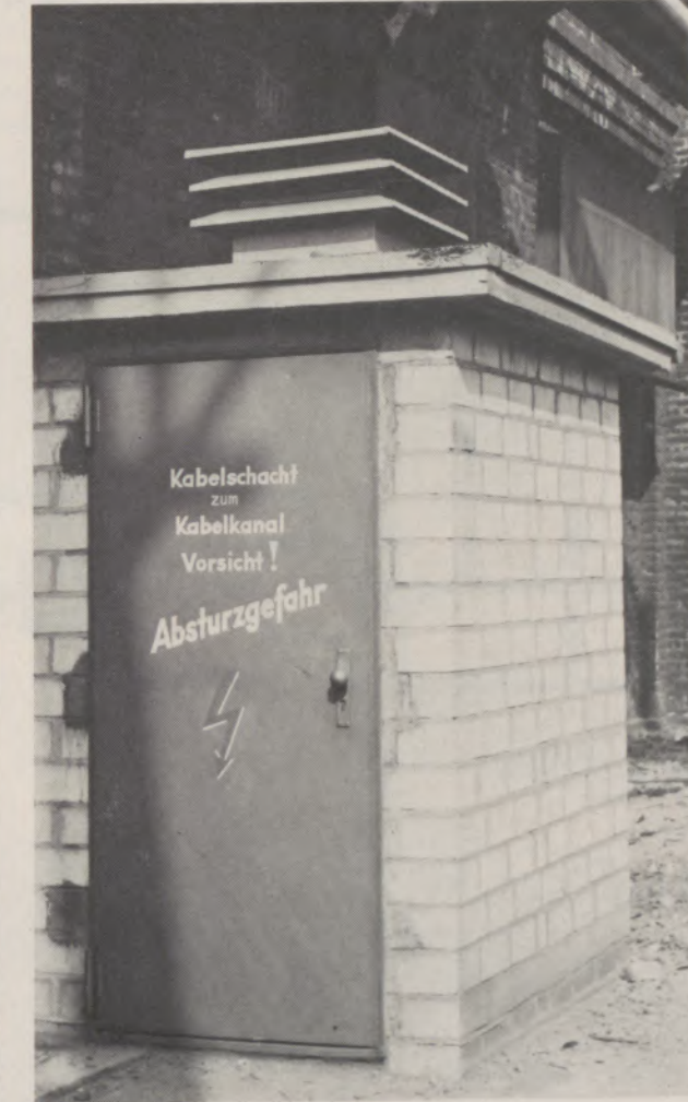
Neuer Einstieg in den Kabelkanal an der Ilgner-Anlage, Werk Union. Der frühere Zugang durch die Ilgner-Anlage wurde zugemauert.
