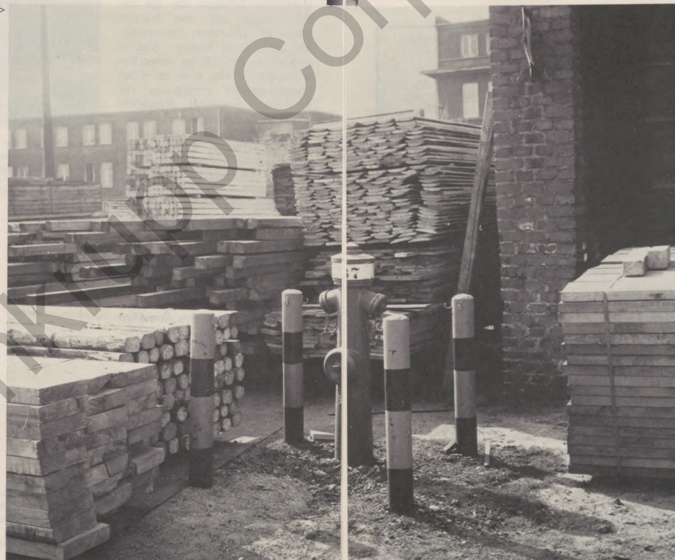
Überflurhydrant in einem Holzlager. >
