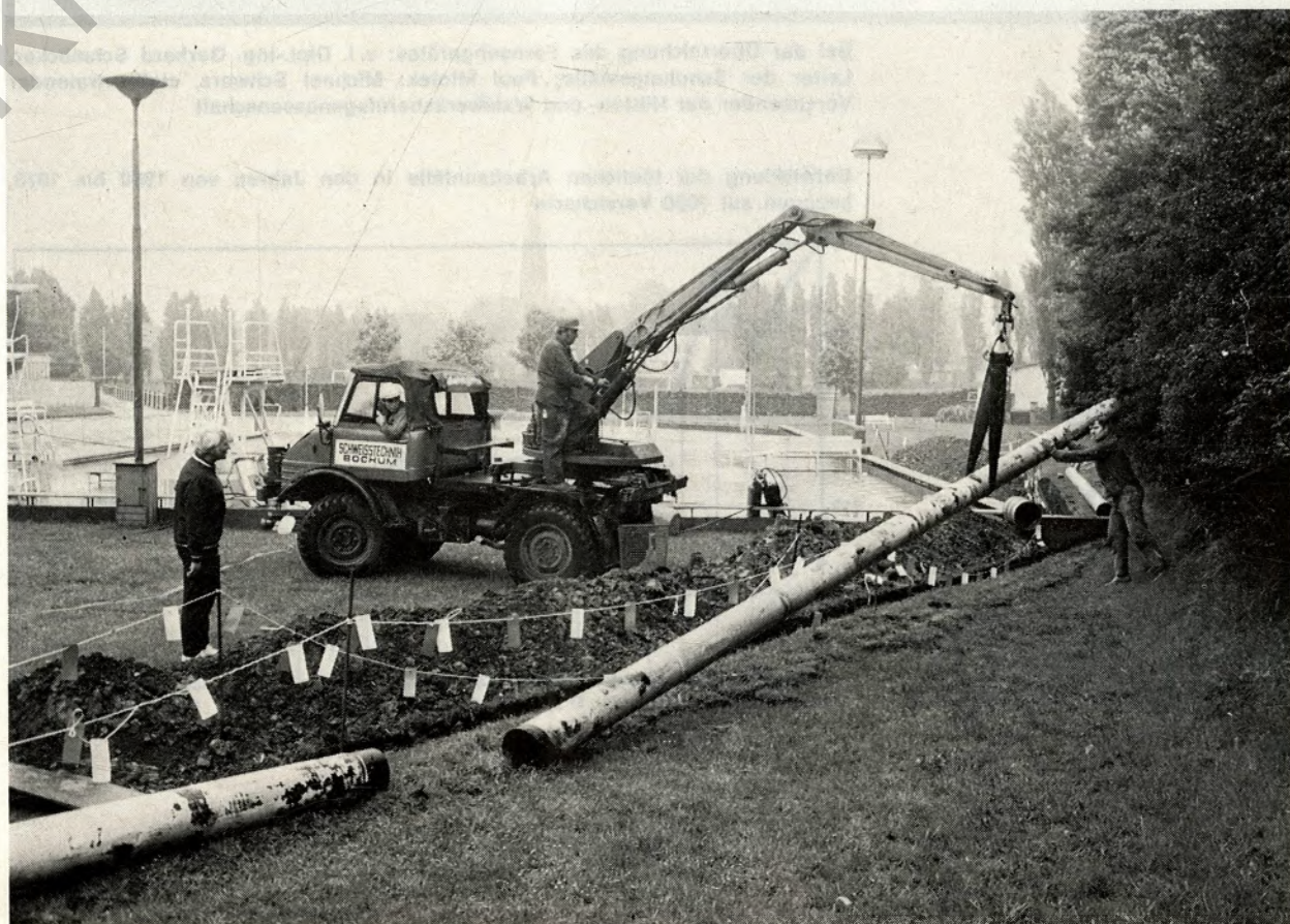
Bei der Verlegung der Rohrleitung für die Umwälzanlage im Schallackerbad, DO-Hörde. Im Bild links Schwimmmeister Fritz Ehrlichmann.
