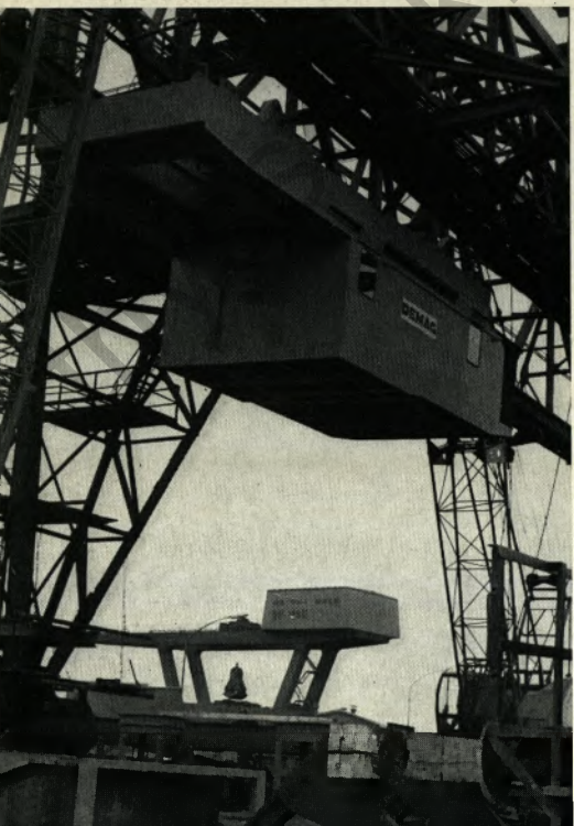
Das Heben ist beendet, und die Fahrwerke werden eingehängt.
