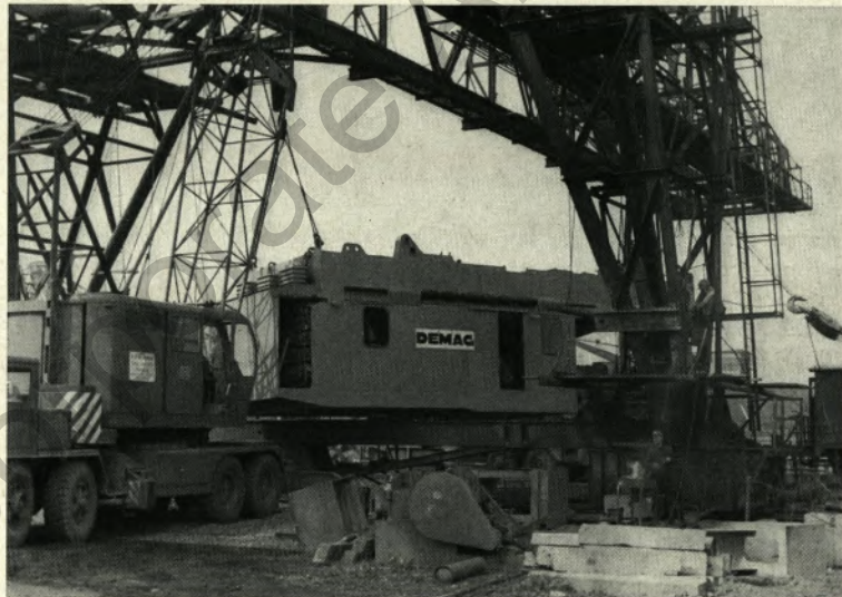
Nach der Demontage mit Hilfe von zwei Autokranen wurde die alte Katze im wasserseitigen Ausleger abgelassen und hier verschrottet.
