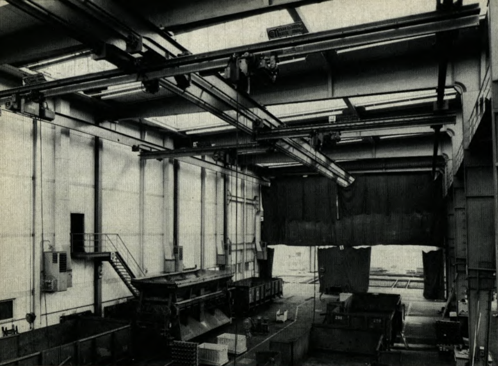
Die vier in Halle 13 angeordneten Hängelaufkrane mit Elektrozug-Laufkatzen. Die beiden Krane im Vordergrund sind im Augenblick miteinander verriegelt. Dadurch besteht die Möglichkeit, die Laufkatzen von einem zum anderen Kran überfahren zu lassen und mit ihr Material von der einen Hallenseite quer zur Längsrichtung zur anderen Seite zu transportieren. Darüber hinaus kann mit einem Kran bei Einsatz von zwei Katzen das doppelte Gewicht angehoben werden.
