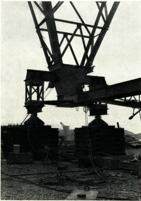
Die Hauptstütze der Brücke III mit dem veralteten Fahrwerk. Der Antrieb befindet sich auf einer zwölf Meter hohen Bühne. Im linken Brückenbein ist deutlich die von oben kommende Antriebswelle zu erkennen.
