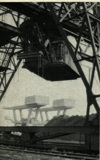
Verladebrücke III mit der alten Drehlaufkatze, Baujahr 1928.
