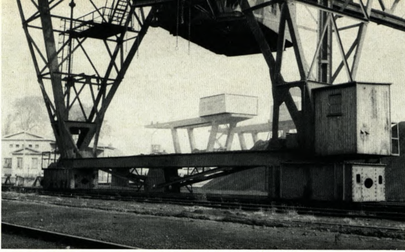
Die Hauptstütze der Brücke III mit dem veralteten Fahrwerk. Der Antrieb befindet sich auf einer zwölf Meter hohen Bühne. Im linken Brückenbein ist deutlich die von oben kommende Antriebswelle zu erkennen.
