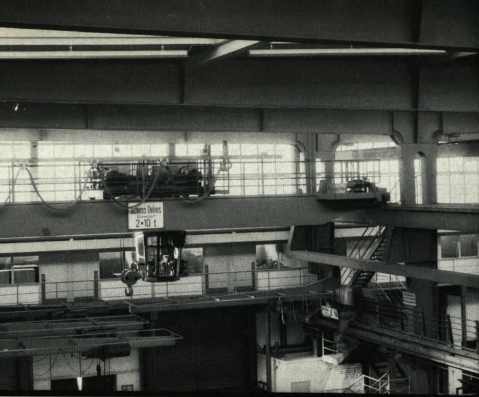
enlaufkrane in Halle 12, der sich, wie unser Bild zeigt, in seiner Kastenträger-Bauweise gut der Das gleiche kann man auch von den darunter laufenden Konsolkranen sagen.
