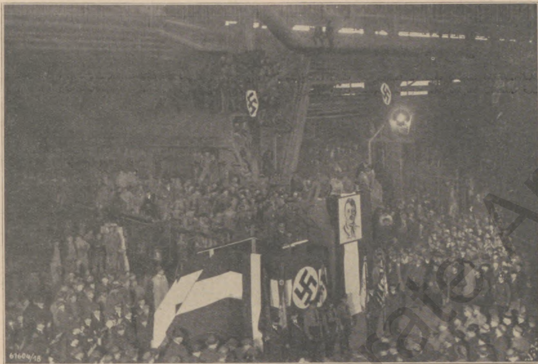
Die unmöglichsten Plätze haben sich besonders findige Werkkameraden ausgesucht, um den Reichsarbeitsminister bei seiner Rede besser sehen zu können. So waren die Pressen bis oben hin besetzt (rechts im Bild). Auch auf den Decken der Dcken, auf den Kranbahnträgern, den Kranbahnen selbst, sowie auf jedem Werkstück, das eine bessere Aussicht bot, war jedes Fleckchen ausgenutzt.
