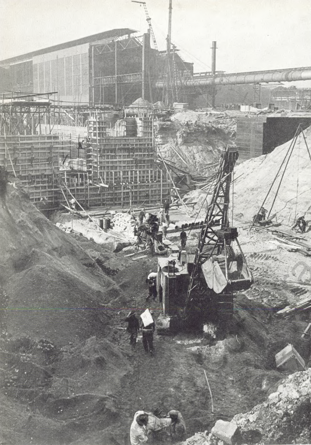
Diese Aufnahme wurde am 20. Oktober 1955 gemacht. Während im Vordergrund noch Bagger mit Ausschachtungsarbeiten beschäftigt waren, wuchsen bereits die Fundamente für die Ofen. Rechts fertige Gebäudestützen der Gießhalle. Im Hintergrund die Tiefofenhalle
