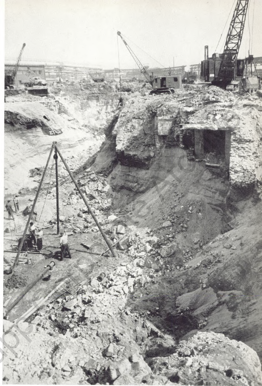
Im Juli 1955 begannen die Ausschachtungsarbeiten für das neue SM-Werk. Fundamente und Ziegelmauerwerk des von August Thyssen vor 65 Jahren errichteten ersten Martinwerkes mußten beseitigt werden. Um den Grundwasserspiegel zu senken, wurden 18 Brunnen gebohrt. Auf dem Bilde links in der Grube sind Arbeiter dabei, einen provisorischen Brunnen anzulegen
