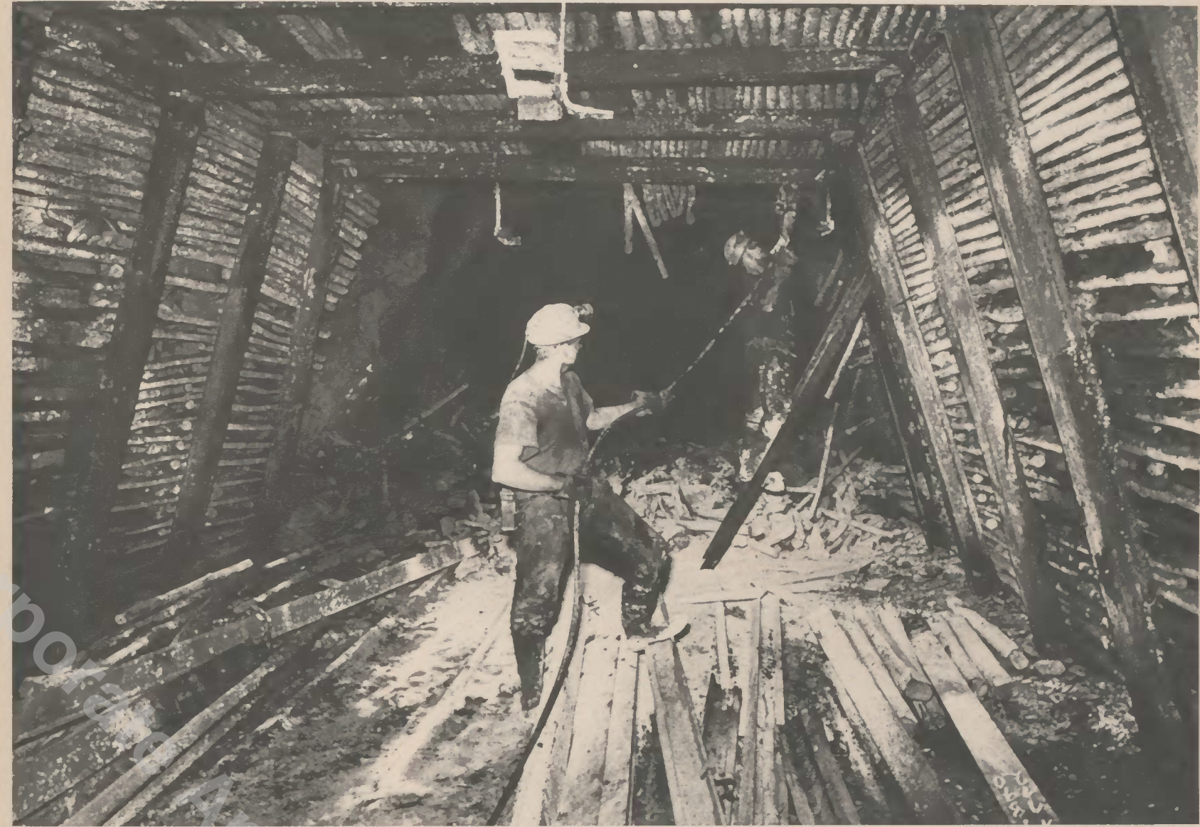
▲ Beim Rauben des Querschlags der 2. Teilsohle in der Abteilung S O 4 befestigen die Hauer Sigurd Tews und Emil Golda das Raubseil an der Kappe, um dann den Ausbau mit der Winde einzuziehen
