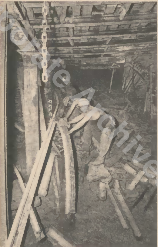
▲ Auf der 7. Sohle wird der Querschlag Nordost I bis zu einem Streckenabzweig ausgebaut. Hauer Willi Schnabel ist mit seinen zwei Kollegen dabei, Ausbauteile zu bergen
