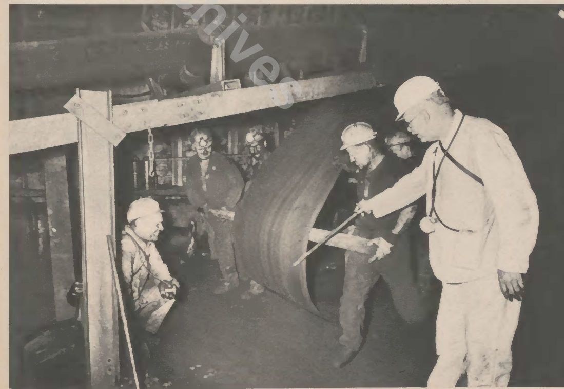
▲ Beim Rauben des Querschlags der 2. Teilsohle in der Abteilung S O 4 befestigen die Hauer Sigurd Tews und Emil Golda das Raubseil an der Kappe, um dann den Ausbau mit der Winde einzuziehen
