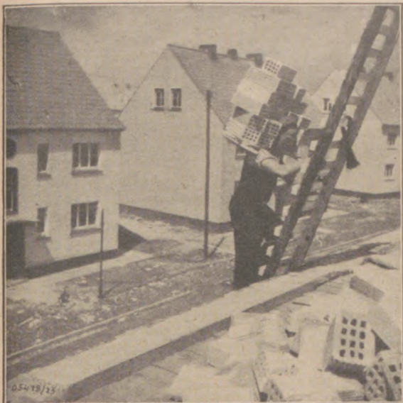
Wird an der einen Ecke noch fleißig gebaut — —
