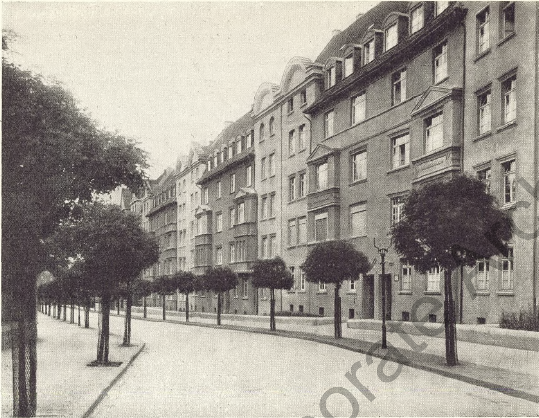
Architekten: Strunck & Wenzler, B.D. A. Dortmund Beamtenwohnhäuser der Dortmunder Union Ruappenberger Straße
