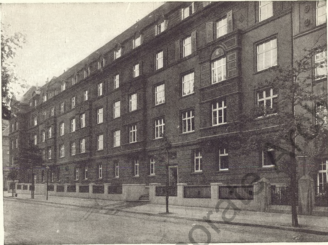
Architekt: Reg.-Baumeister Anton Dengler Beamtenwohnhäuser der Dortmunder Union Dortmund, Hindemannstraße
