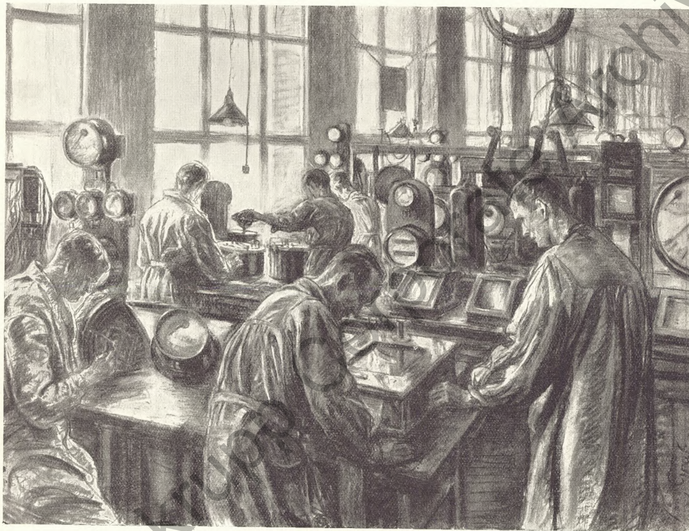
Eichraum für Registrierinstrumente im Wernerwerk M der Siemens & Halske A.-G. Jedes fertige Meßinstrument wird erst langdauernden und sorgfältigen Prüfungen unterzogen, ehe es das Werk verläßt Nach einer Originalzeichnung von Franz Graf
