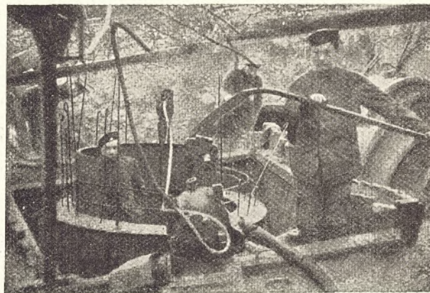
Abb. 6. Abteufen des Schachtes „Gerhard“ als Betonsenkenschacht in offener Baugrube, am Badhof bei Meesen (Messines)
