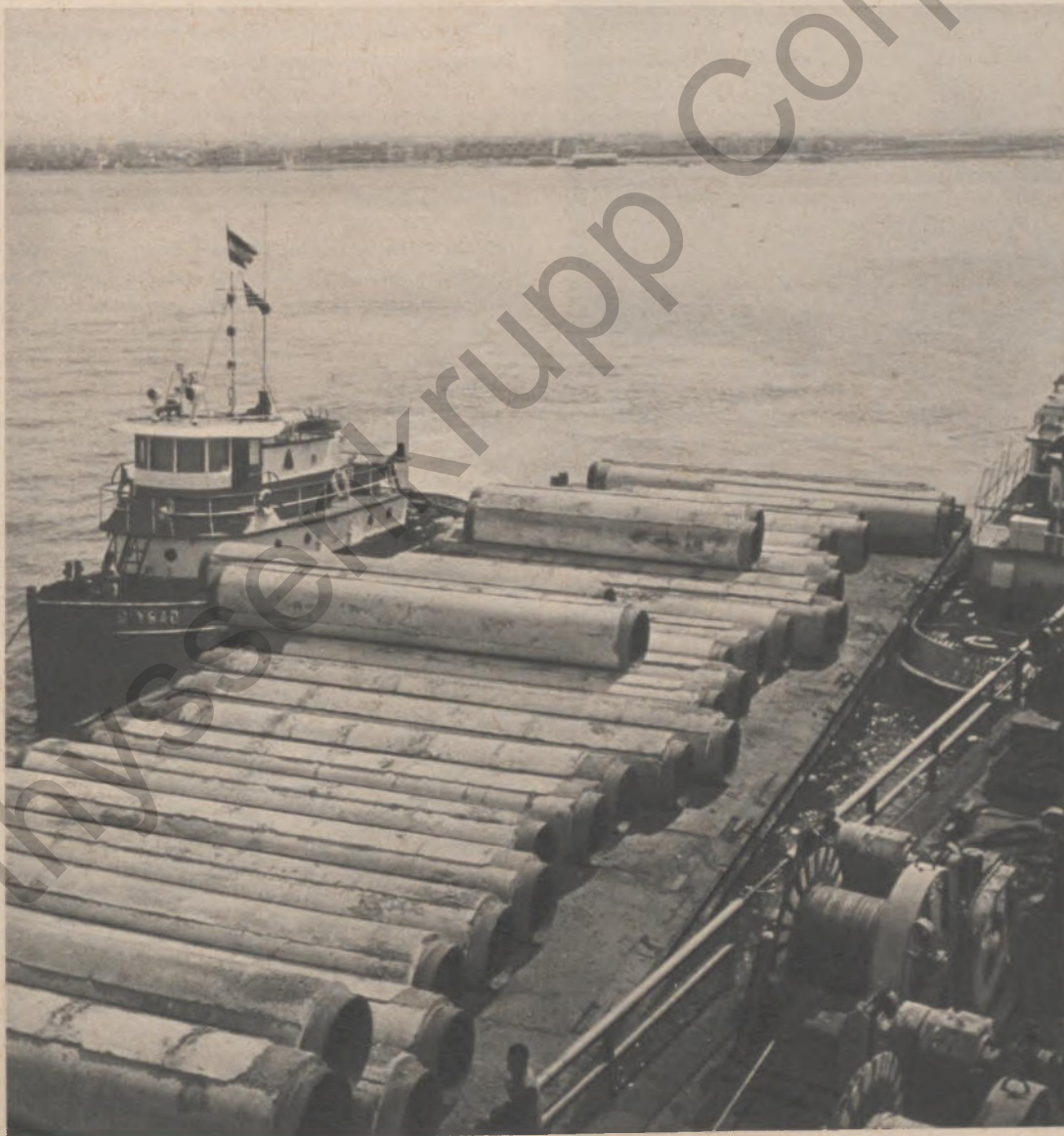
▲ Blick auf die Schweiß-, Verlege- und Absenkbahn der 125 Meter langen „Barge“, auf der aus einzelnen Rohren der Strang entsteht. Das Verleges Schiff wird seewärts unter der entstehenden Leitung weggezogen – siehe das Titelbild dieses Heftes
