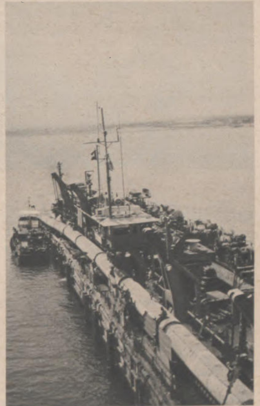
▲ Blick auf die Schweiß-, Verlege- und Absenkbahn der 125 Meter langen „Barge“, auf der aus einzelnen Rohren der Strang entsteht. Das Verleges Schiff wird seewärts unter der entstehenden Leitung weggezogen – siehe das Titelbild dieses Heftes
