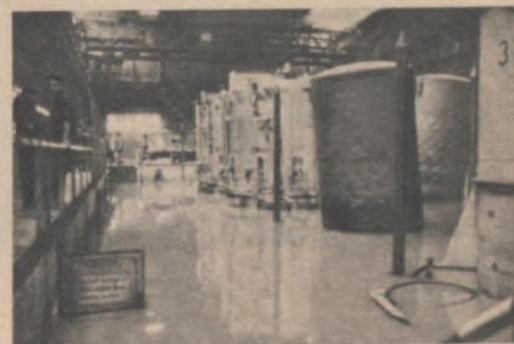
▲ Auch in der Glüherei richtete das Hochwasser erhebliche Schäden an
