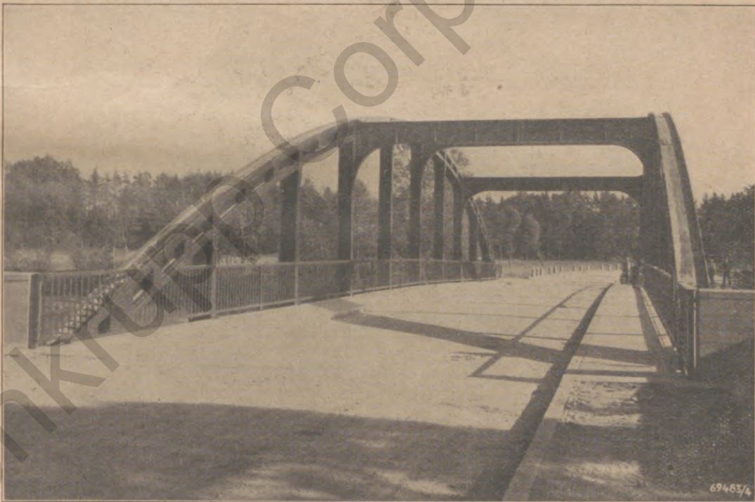
Straßenbrücke über den Algen
