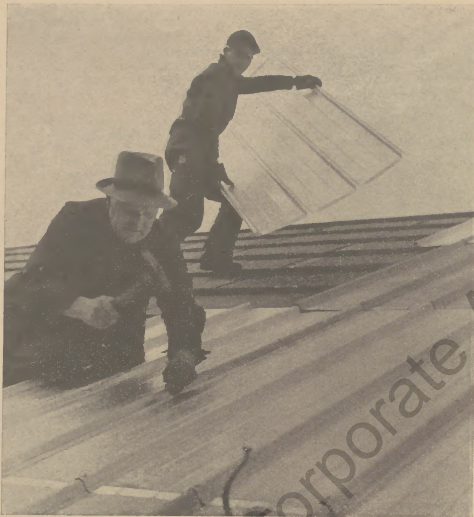
Verlegung von verzinkten Stahldachpfannen auf dem Dach des Gymnasium-Neu- baues in Siegen (Juli 1953).
