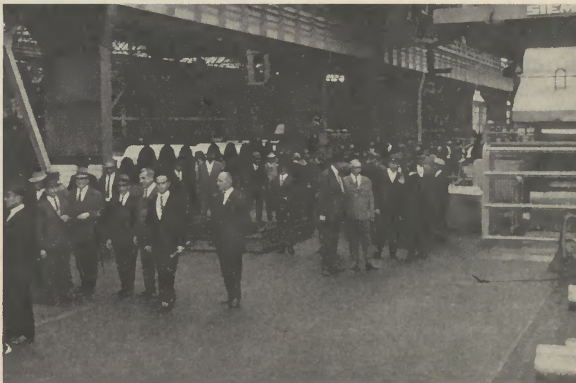
Die Pensionäre beim Betriebsrundgang im Kaltwalzwerk. Rechts das neue Reversiergerüst.
