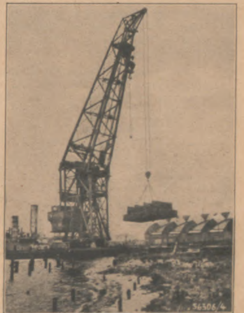
Bild 3: Der riesige Schwimmkran in Wilhelmshaven, genannt „Langer Heinrich“
