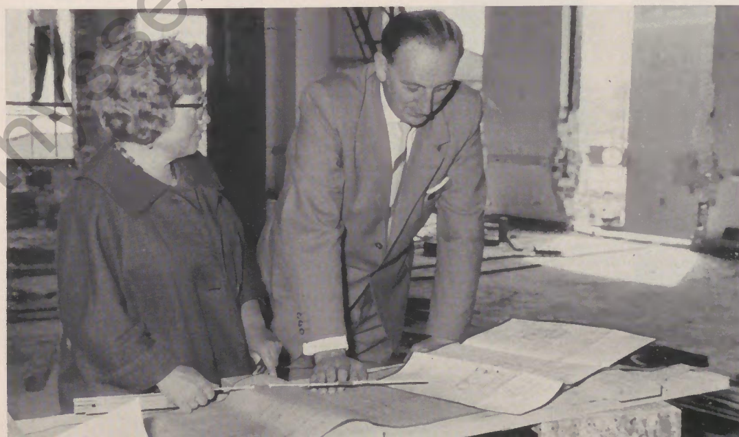
Frl. Thea Kirchstein von der Henschel-Bauleitung und Küchenleiter Theodor Vater im zur Baustelle verwandelten großen Speisesaal in K 9 bei der Besprechung von Plänen.
