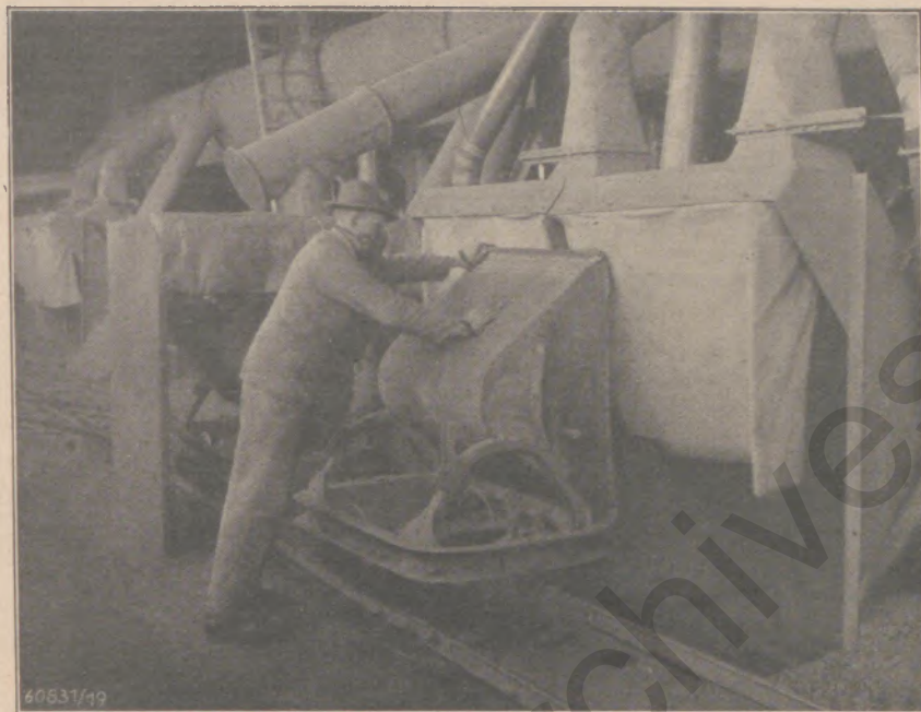
Bild 29: Bekämpfung der Staubbelastigung durch vorgebundene Tücher und Abstellung des geleerten Wagens unter einer Kammer, beiderseits in Verbindung mit einer kräftigen Ventilation
