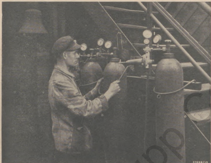
Bild 22: Sicherung von Gasflaschen gegen Umfallen in der Kesselschmiede (Einlegen des Haltebügels)
