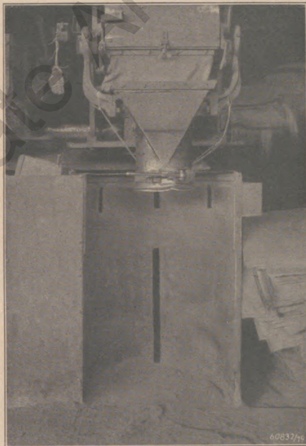
Bild 29: Bekämpfung der Staubbelastigung durch vorgebundene Tücher und Abstellung des geleerten Wagens unter einer Kammer, beiderseits in Verbindung mit einer kräftigen Ventilation
