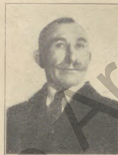
Zimmerer Albert Birkhahn Bauabteilung Thyssenhütte am 4. 1. 11
