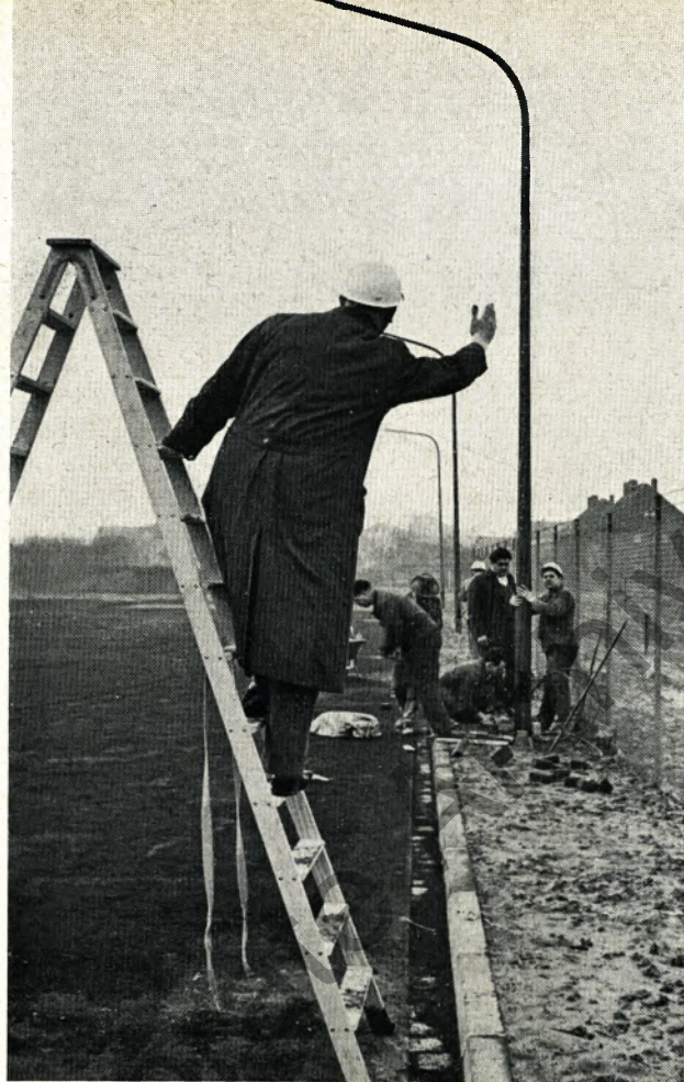
Auf dem neu angelegten Parkplatz unseres Hildener Betriebes werden z. Z. Lichtmaste aufgestellt, die im Werk Dinslaken gefertigt wurden
