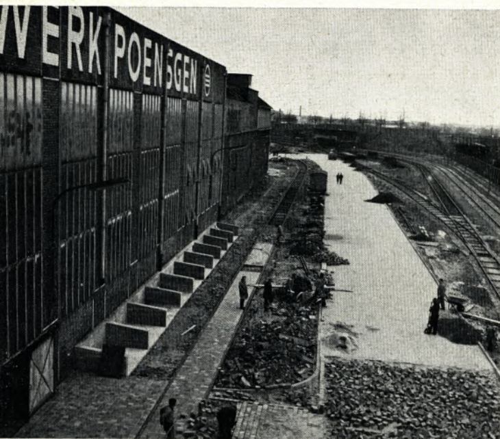
Neue Schienen- und Straßenwege entstehen im Werk Poensgen. Um Gefahrenstellen zu vermeiden, werden die Werksstraßen von Kreuzungen freigehalten
