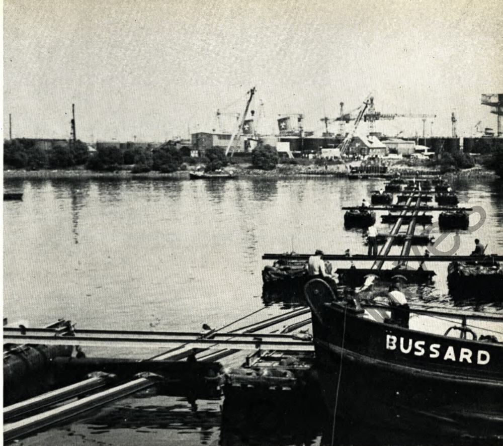
Eine Dükerverlegung nach dem »Klappverfahren« geht optisch verhältnismäßig einfach zu. Hier sehen wir die Düker-Doppelleitung über den Köhlbrand, wie sie von den 7 Schlauchbootpaaren gehalten wird
