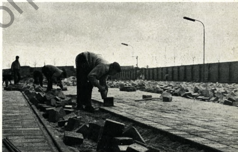
Noch vor Einbruch des Winters sollen die Bauarbeiten an den Werksstraßen und den Schienenwegen abgeschlossen sein. Die Pflasterer arbeiten mit Hochdruck
