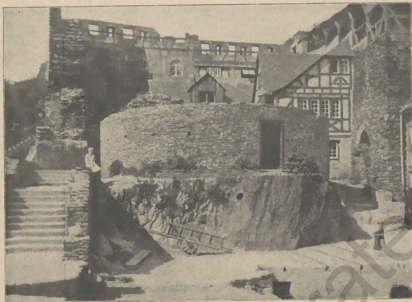
Ruine Stahlwerk bei Bacharach am Rhein Aufnahme von A. Goss, Elektrotechn. Abt., Förder Verein
