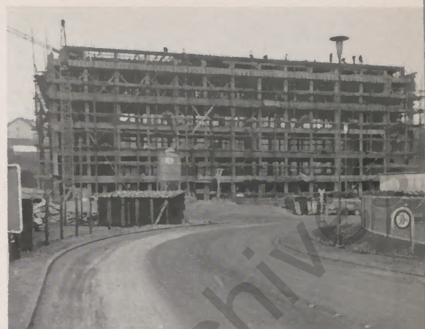
Betonierungsarbeiten beendet: Anfang September 1959 begannen die Ausschachtungsarbeiten zum Bau der neuen Versuchsanstalt (einschließlich Abnahme) der Henrichshütte. Inzwischen konnten die Betonierungsarbeiten am Haupttrakt abgeschlossen werden, während die Bauarbeiten am Quertrakt kürzlich angelaufen sind. Die neue Versuchsanstalt, die schließlich vier Gebäudetrakte umfassen soll, wird wegen der komplizierten Haustechnik voraussichtlich erst Anfang 1961 bezugsfertig; im Sommer 1960 soll der Rohbau fertig werden.
