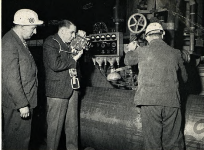
Das Fernsehen berichtete über den Bau der Pipeline Marseille-Karlsruhe und machte für den Bericht auch Aufnahmen in unserem Mülheimer Großrohrwerk von der Herstellung der für die Pipeline benötigten Rohre
