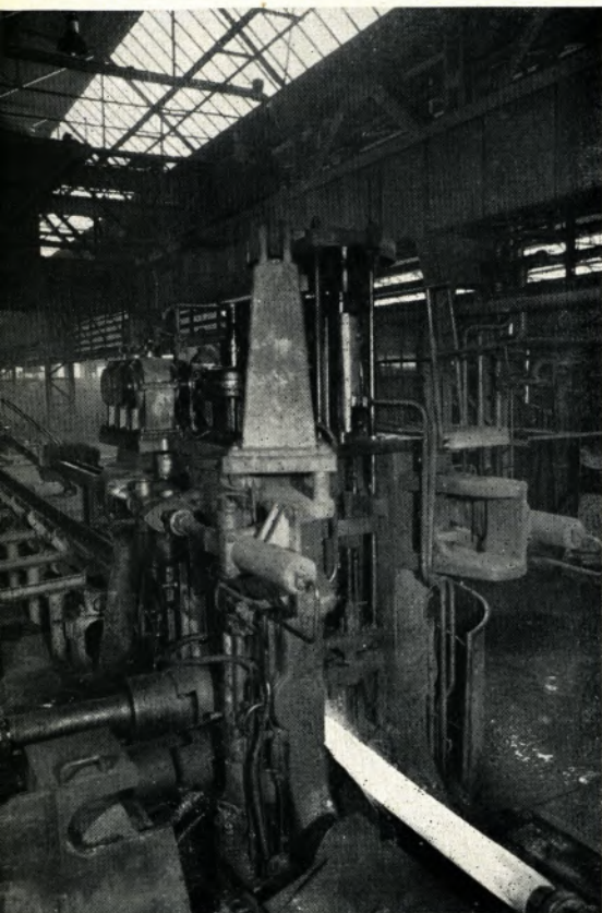
Bild links zeigt das Pilgergerüst in unserer Mülheimer Anlage. — Daneben: Blick auf die Pilgerstraße im Werk Thyssen, Mülheim, auf der Rohre bis zu einem Außendurchmesser von 178 mm und Wanddicken von 3 mm bis 35 mm für viele Zwecke hergestellt werden
