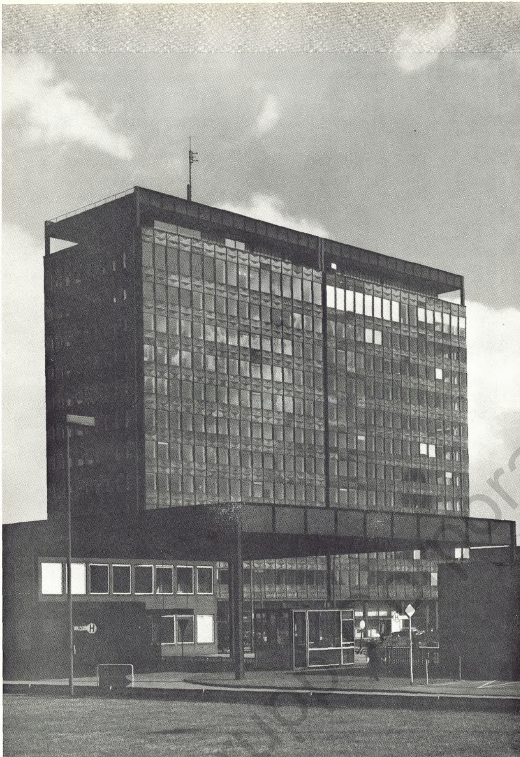
DAS NEUE VERWALTUNGS-HOCHHAUS der ATH, das im Laufe dieses Sommers von über siebenhundert Mitarbeitern bezogen werden konnte, wird am 4. November im Rahmen einer kleinen Feier eingeweiht und seiner Bestimmung übergeben. Im Weihnachtsheft wird die Werkzeitung ausführlich über das ATH-Haus berichten.
