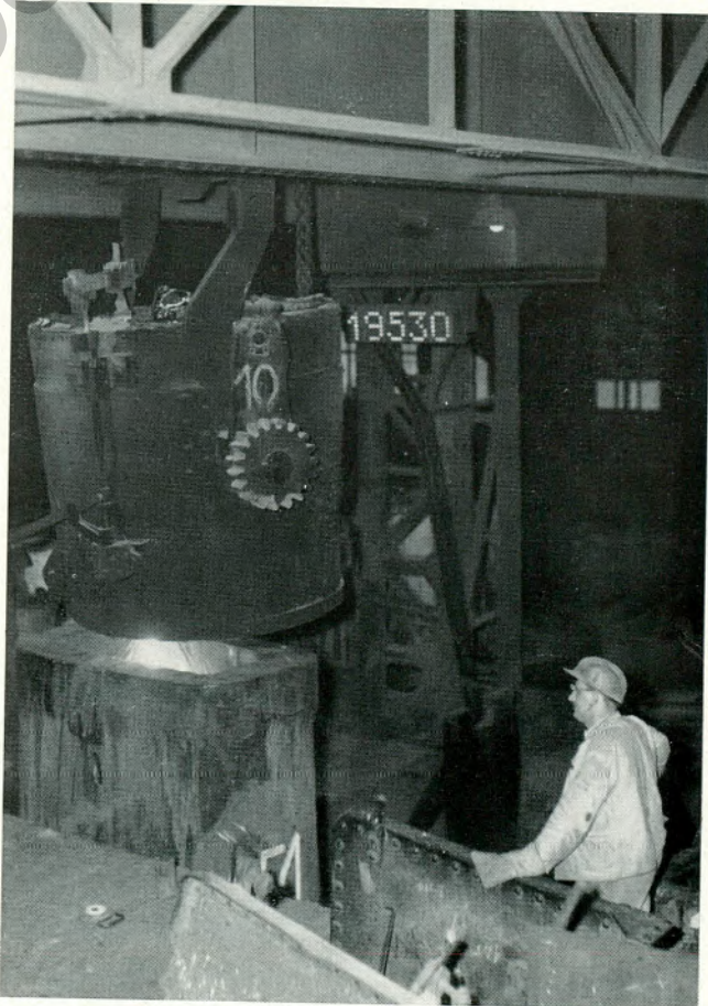
Abb. 5 Gießkatze im Thomas- stahlwerk Hörde mit wahlweiser Leucht- ziffernanzeige des Pfanneninhaltes oder des Brammengewichtes
