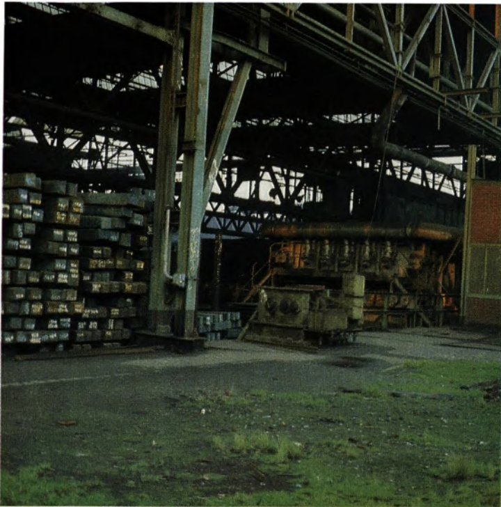
Teilansicht des Halbzeuglagers in Halle 1 und Stirnwand des Durchstoßofens (A) mit den fünf Brennern.
