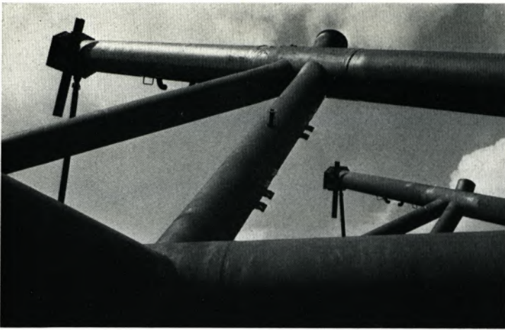
Bei den geschweißten Knotenpunkten der Unterkonstruktion für die Forschungsplattform Nordsee hat Krupp Industrie- und Stahlbau calciumbehandelte Sonderstähle der Thyssen Niederrhein AG eingesetzt.
