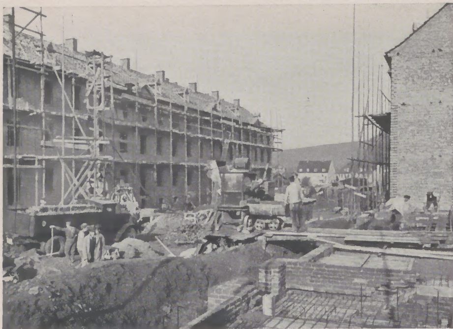
Bild oben und unten: Die Neubauten an der Holländischen Straße in Kassel Aufnahmen: H & S
