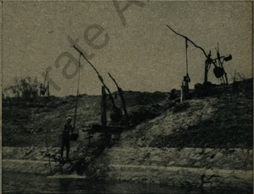
Noch heute wie vor 5000 Jahren wird mit dem Schaduf das Wasser aus tieferen Gräben in höhere befördert. Ein Gegengewicht aus trockenem Lehm erleichtert das Heben des Eimers. Meist werden mehrere dieser Hubwerke hintereinander benutzt, um größere Hubhöhen zu erreichen.
