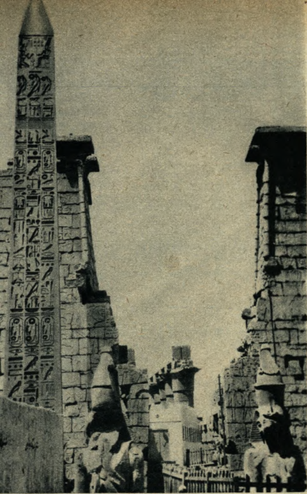
Eingang zum Tempel in Luxor. Links Standbild und Obelisk noch 6 m unter dem neuen Straßenniveau im Bauschlamm vergraben. Die Freilegung des rechten Standbildes durch einen Zaun geschützt.
