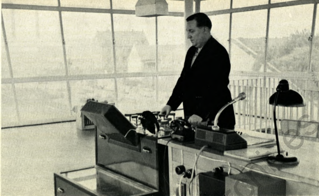
Der Weichensteller Walter Braun im neuen Stellwerk. Übersichtlich angeordnet vor ihm auf einem Signalpult die Hebel für Signale und Weichen; zu seiner Linken die Wechsel-Lautsprecheranlage, die ihn mit den verschiedensten Außenstellen verbindet.
