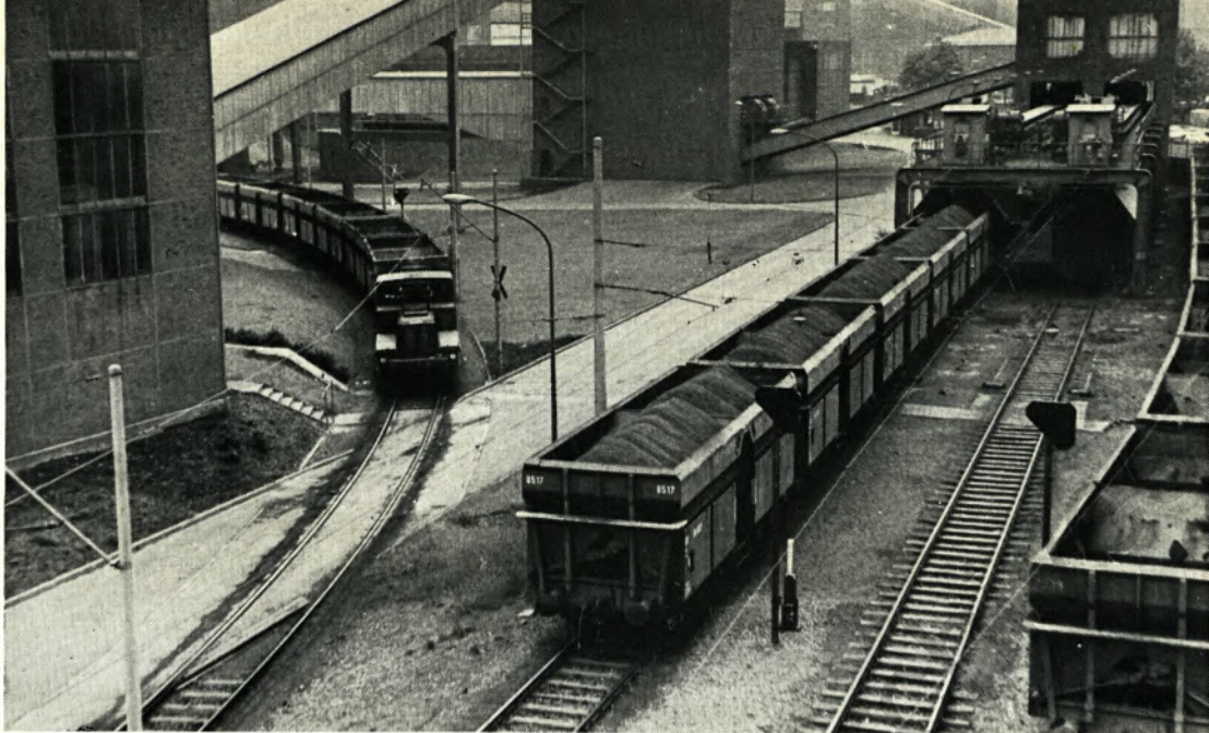
Vom Stellwerk sieht man direkt auf die Beladeanlage der „Ebus“. Dort wird das gebrochene und gesiebte Erz mittels Band auf die Erz-Selbstentladewagen geladen. Links im Bild kommt gerade ein leerer Zug von Ruhrort auf dem Gleis „Nordhafenfahrt“ angefahren.
