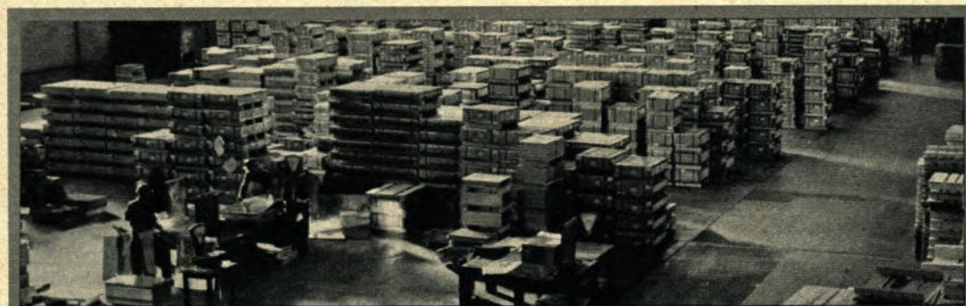
17 Die in Paketen mit einem Gewicht von etwa 1 Tonne verpackten Weißbleche liegen versandbereit in der Lagerhalle.
