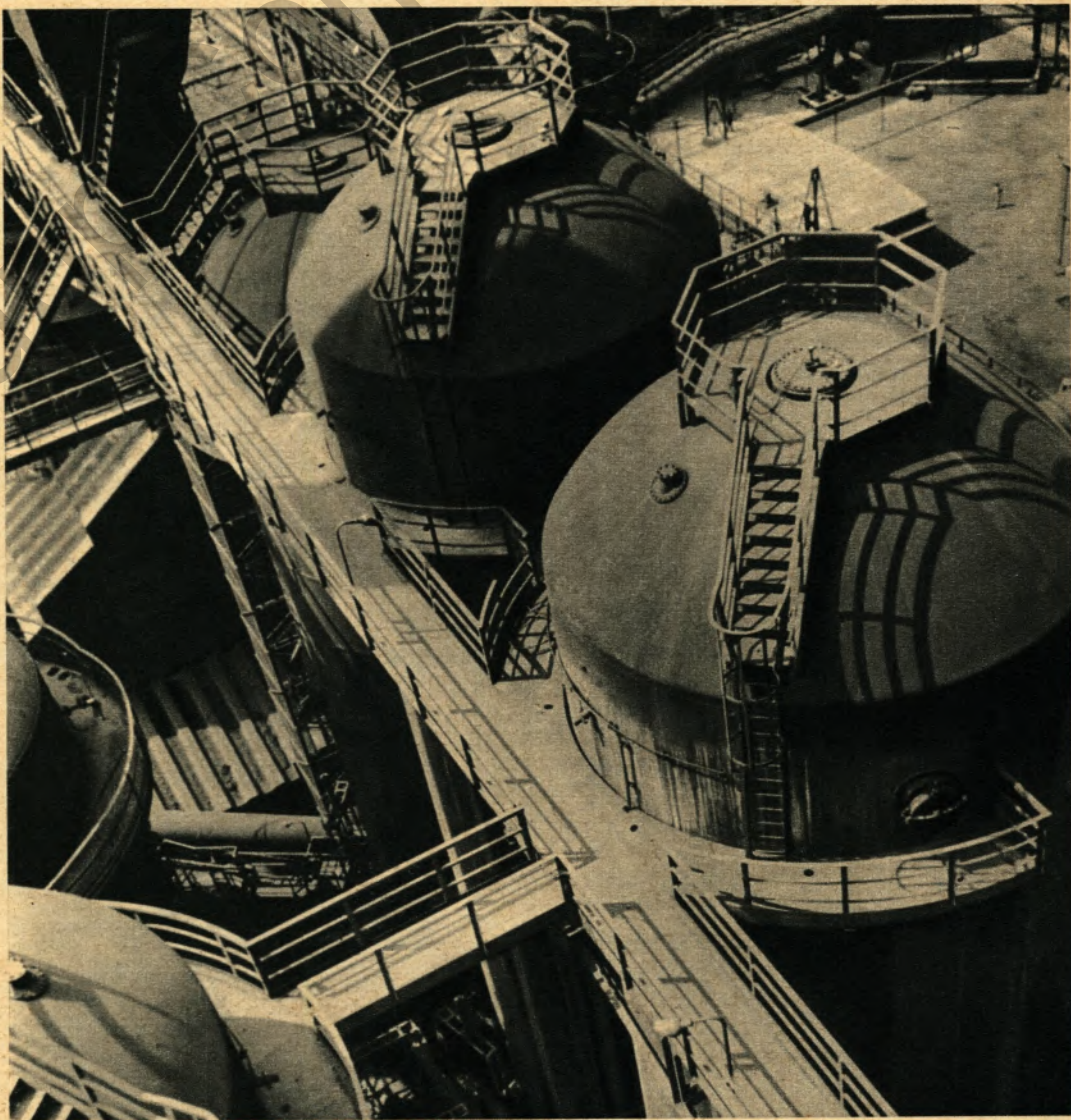
► Etwa ein Viertel des Gichtgases verbrauchen die Hochöfen selber, um den Wind in den Winderhitzern auf die notwendige Temperatur zu bringen
