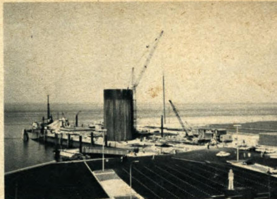
▲ Mit ihren 22 Metern Höhe und einem Durchmesser von 13 Metern überragt diese Spundwandkreiszelle die gesamte Baustelle
