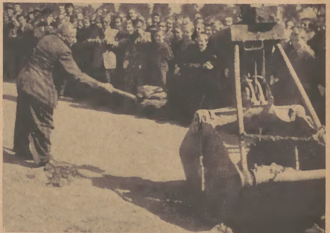
Arbeitsdirektor Berndsen beim ersten Spatenstich
