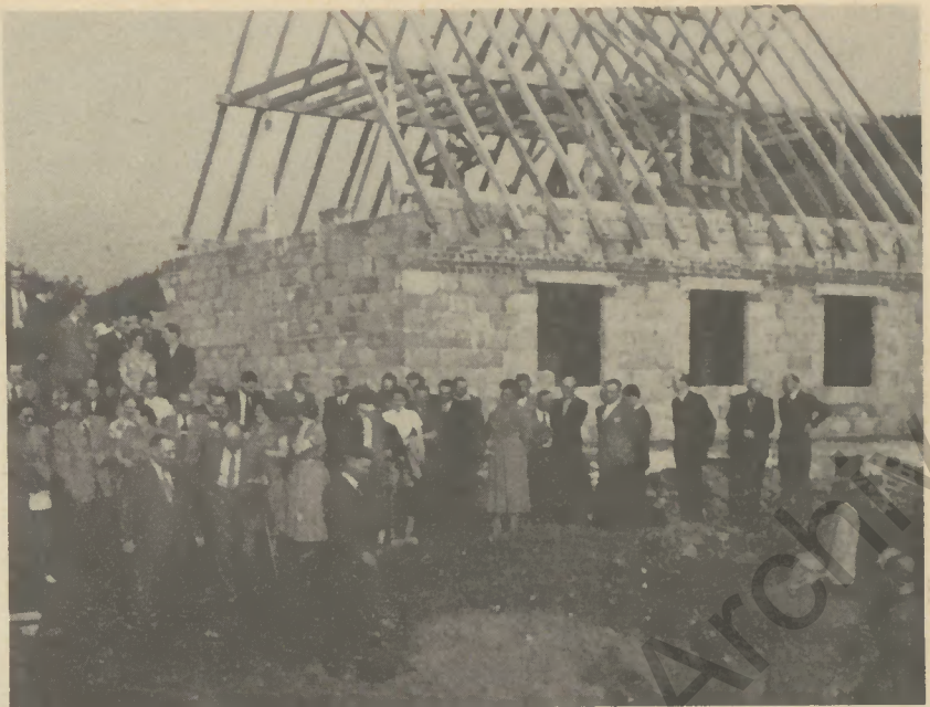
Die traditionelle Feier begann mit dem Richtakt an der Baustelle
