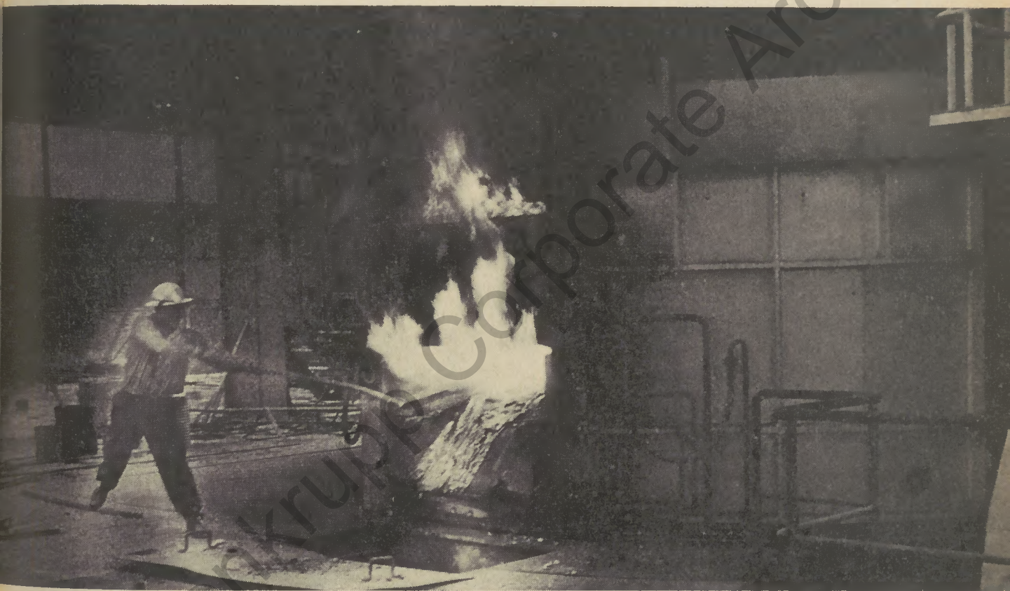
Anschließend wird eine neue, saubere Schlacke durch Zusatz von Kalk und anderen Stoffen aufgebracht.
