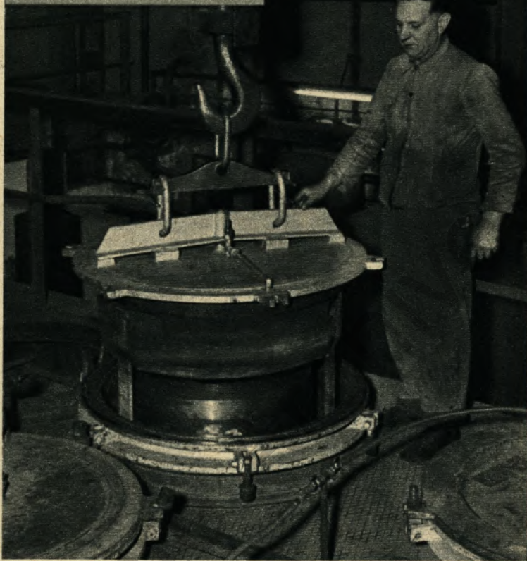
Willi Lemke und die von ihm erdachte Schutzabdichtung
